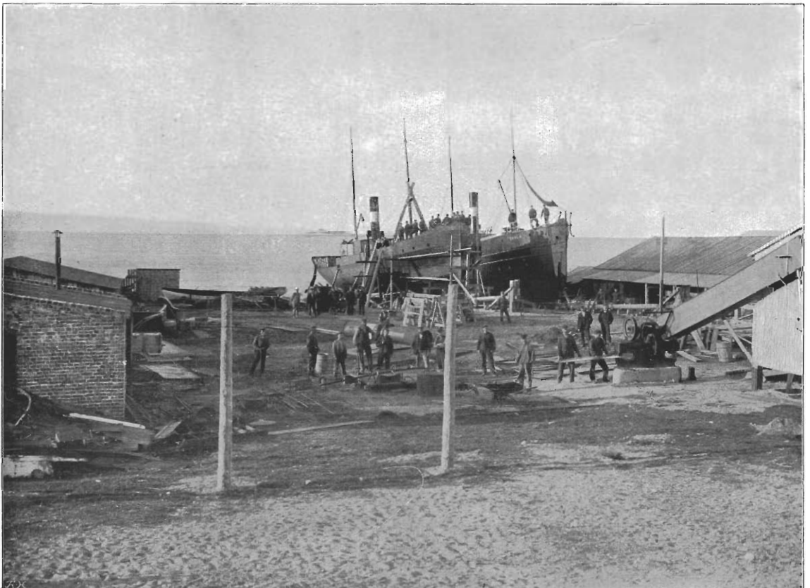
SKIBSVÆRFET I ILSVIGEN HVORPAA DAMPSKIBENE «ORKLA» (FROSTA DAMPSKIBSSELSKAB) OG «GRØTØ» (ARNT SCHØNINGS SØNNER, GRØTØ) REPARERER
